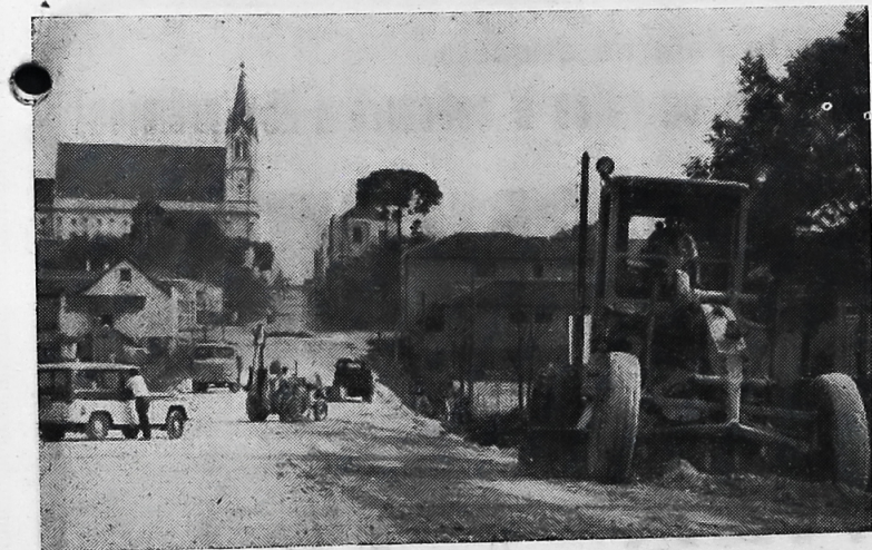
Aspecto da avenida em obras.
