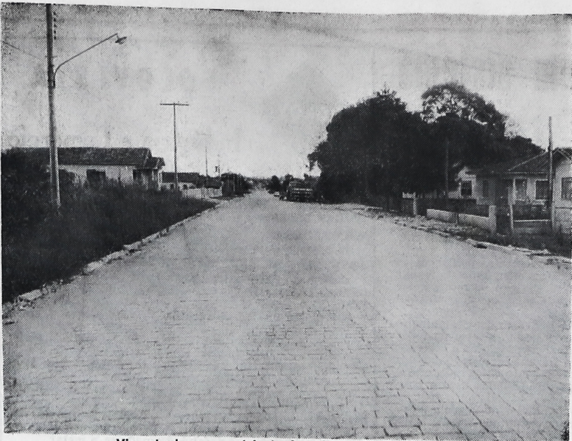
Via calçada em paralelepípedo pela atual administração.
