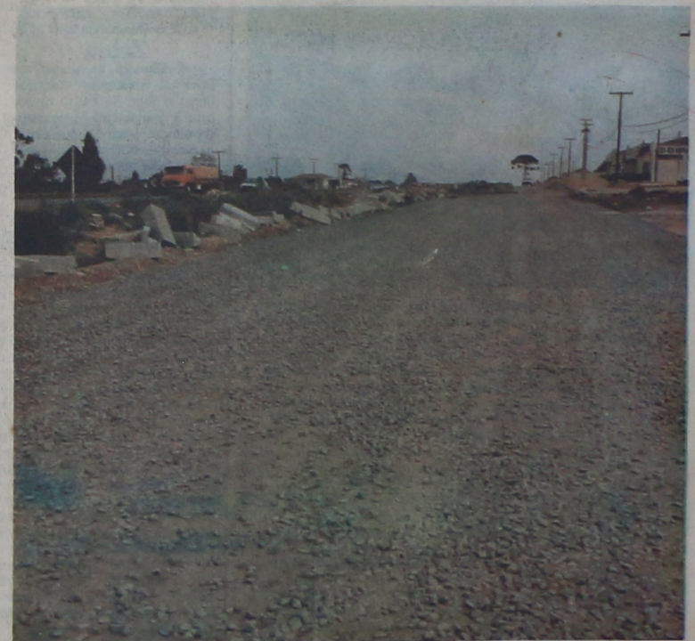
Obras da Marginal à Rodovia BR 277
