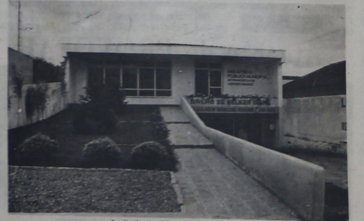
Ampliação da Biblioteca Pública Municipal
