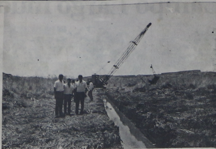
Drenagem do Rio Cambui facilita a vida dos transeuntes.
