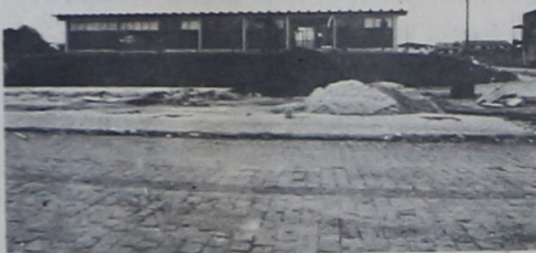
Construção de estacionamento
