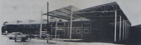
A ampliação da Automec deve ser concluída até dezembro.
