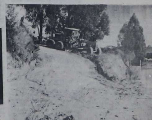
Patrula da Prefeitura agilizando as obras na localidade de Ferraria.
