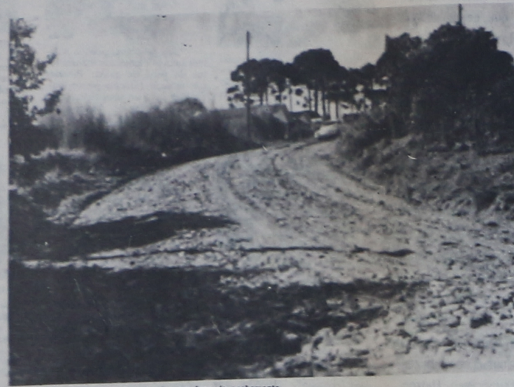
Vila Boa Vista - Obras da Rua Sérgio em fase de acabamento.
