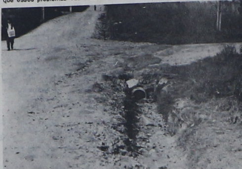
Maniamento e construção de bueiros para escoamento de águas pluviais na Vila Dona Fina, evita erosão e formação de banhedos. Maior segurança à população.
