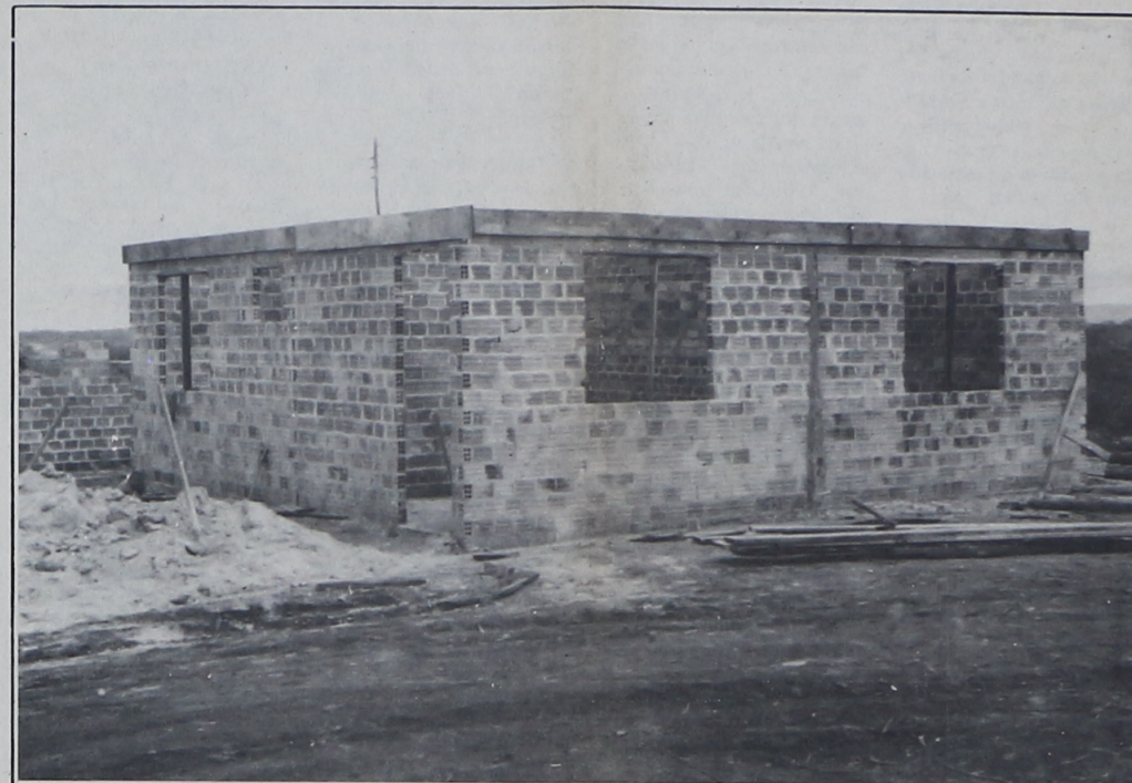
As casas populares do projeto Moradias Parténope já estão sendo construídas conforme a Prefeitura havia prometido.
