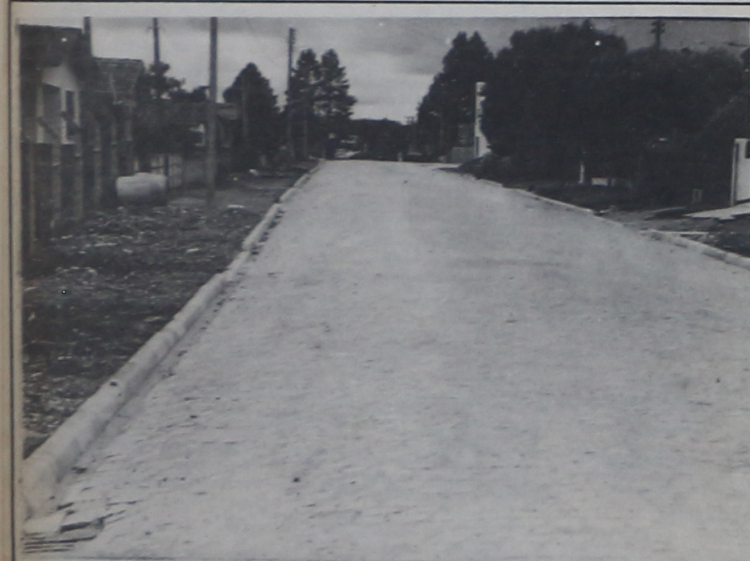
Rua Piauí, no Itaquí, com 310m lineares de extensão: pavimento em paralelepípedo.
