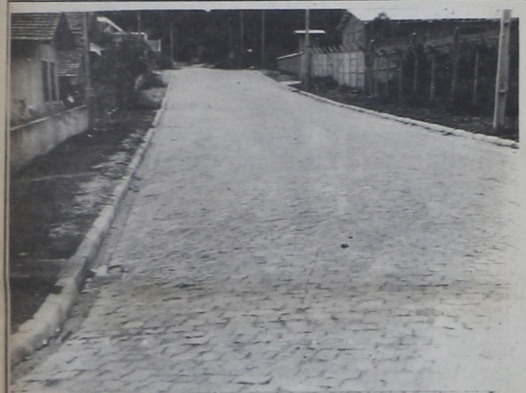
Rua Rondônia, 100m lineares de extensão, com meios-fios e pavimento em paralelepípedo.
