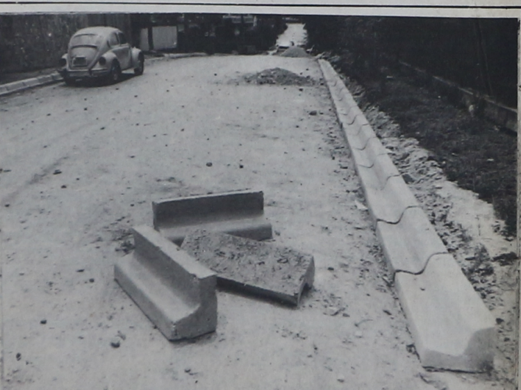
Na Avenida Arlindo Chemin, a Emlar está construindo meios-fios e implantando asfalto.
