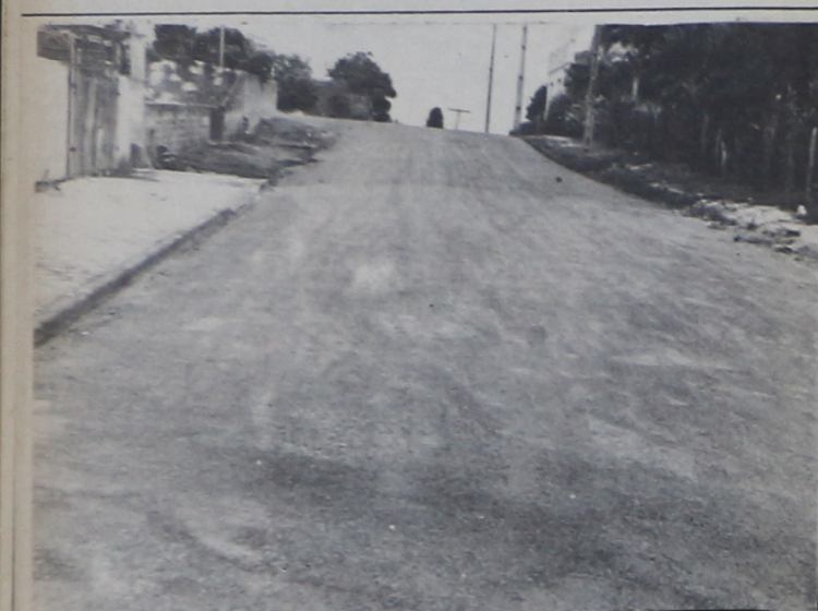
Travessa Iara, no bairro da Aparecida, pavimentada em asfalto nos seus 150m lineares.
