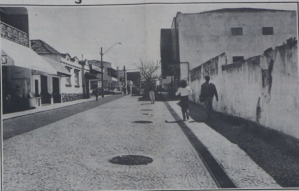
Nem só no trecho do calçadão da Rua XV os proprietários poderiam colaborar para o embelezamento da cidade; em diversos outros trechos de Campo Largo terrenos baldios, muros e casarões estão a merecer trabalhos de remodelação.
