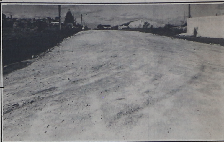
No Loteamento Ouro Verde, ensaibramento beneficiou vários trechos.
