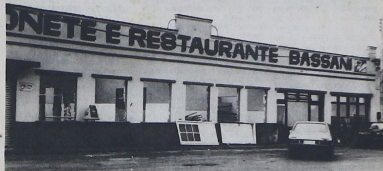
Prédio antigo do Restaurante Bassani, está sendo demolido
