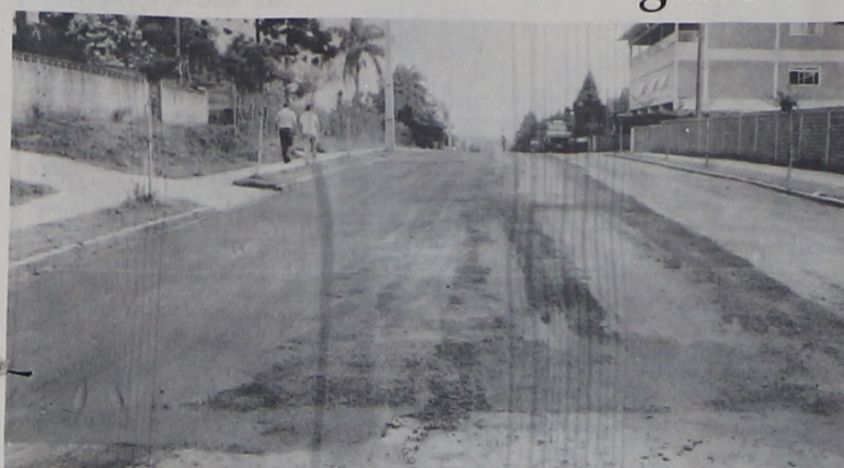
Prefeitura experimenta lama asfáltica para recuperar a Natal Pigatto
