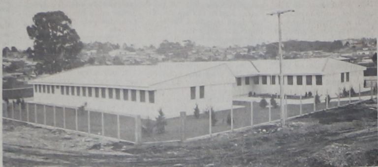
Instalações do Núcleo Integrado de Saúde III, para atendimento médico de urgência
