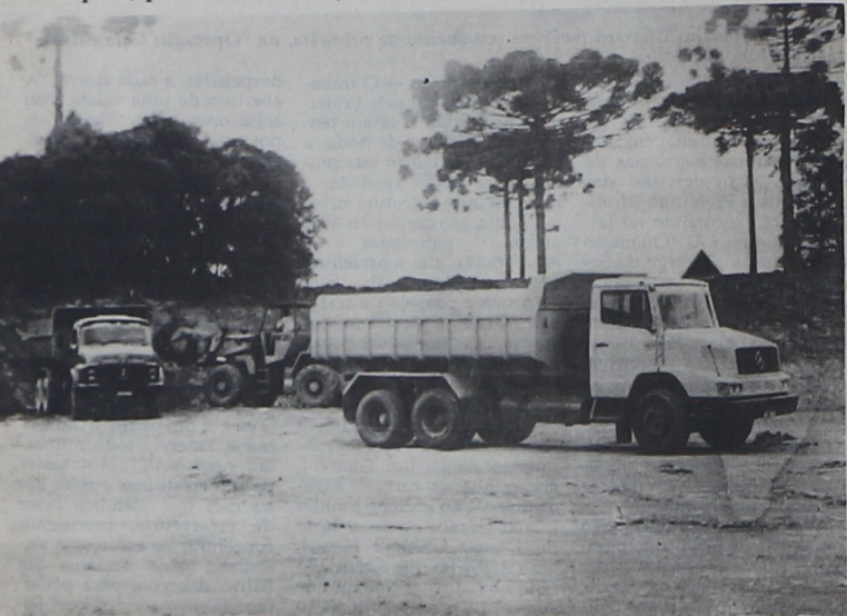
Os caminhões e máquinas da construtora Orlando Pianaro Engenharia Civil, realizam as obras de retoque na pista do aeroporto
