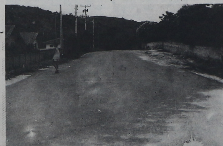
Pavimentação da Rua Paraná, no Jardim Esmeralda
