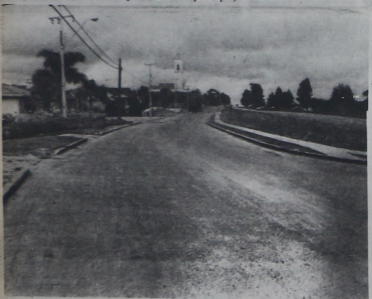
TSD com capa selante na Rua Mato Grosso, entre a Igreja e a BR-277, na Rondonia
