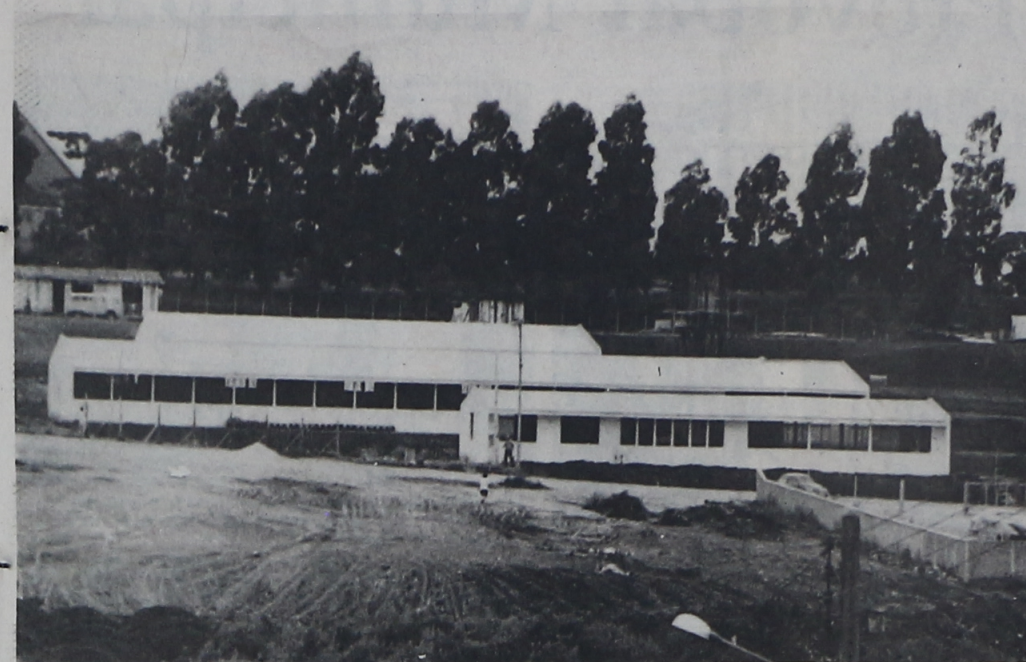
Escola Municipal 1.º de Maio, obra iniciada na administração Affonso Portugal Guimarães, com dez salas de aula e demais dependências. Esta é uma das principais obras da atual administração e deverá estar concluída em março próximo.
