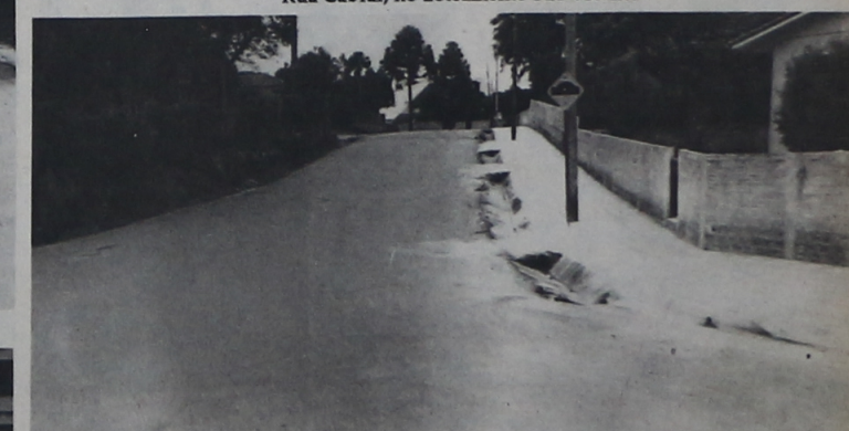
Calçada e acesso ao Núcleo Habitacional Dr. Abranches Guimarães
