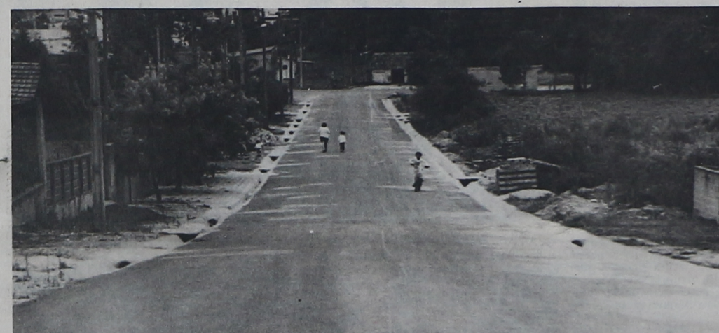
Pavimentação em TSD da Rua Goiás, no Jardim Esmeralda
