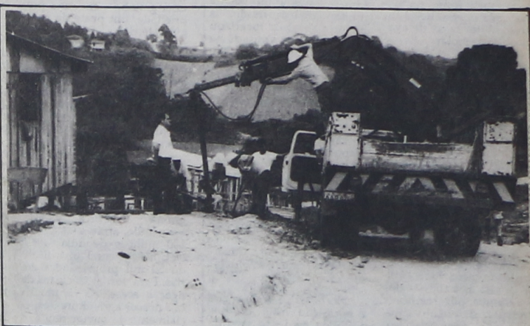
Técnicos da Cocel iniciam a perfuração para implantação da rede de energia no São Lucas
