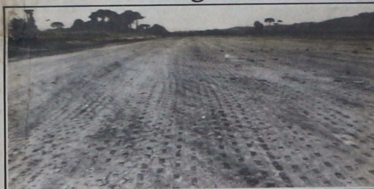
A pista do Aeroporto Alberto Bertelli já está totalmente concluída
