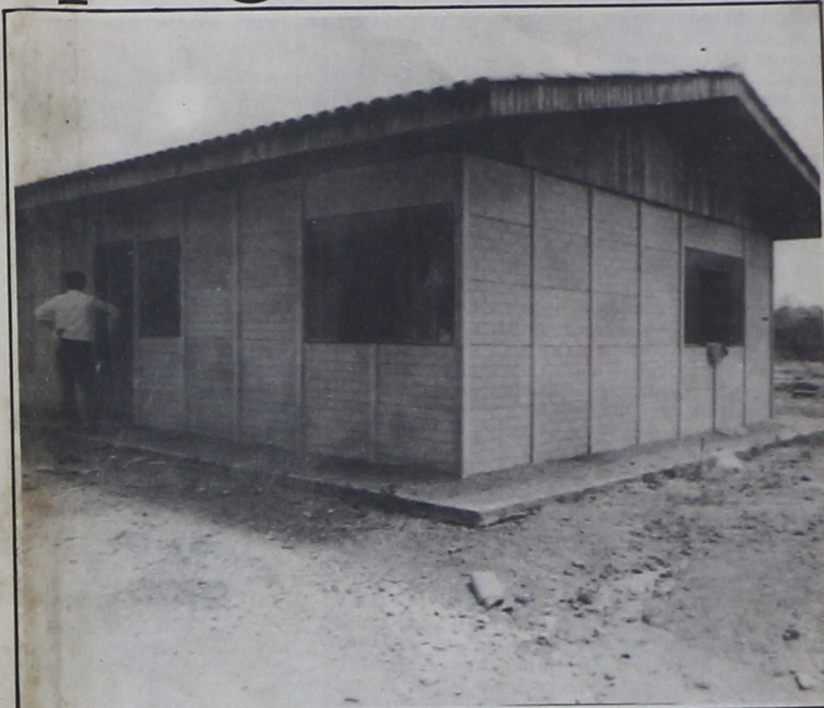
Uma casa pré-fabricada, com módulos de concreto, construída em tempo recorde
