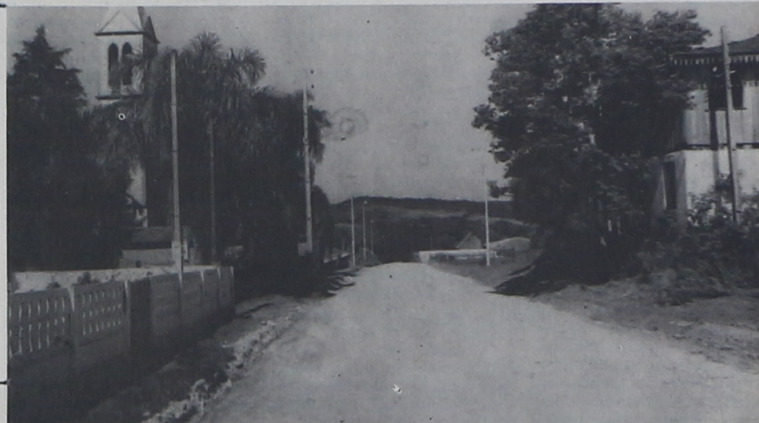
Rua recuperada na Colônia Campina, pela Operação Concentrada
