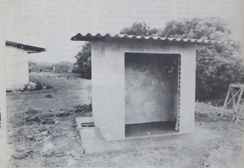
Casa de controle para o abastecimento de água da comunidade
