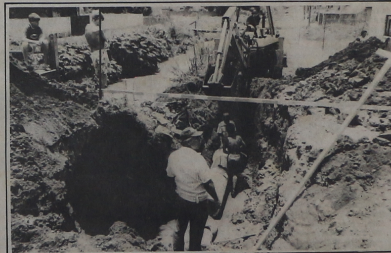
Início das obras de implantação do emissário do Rio Cambuí
