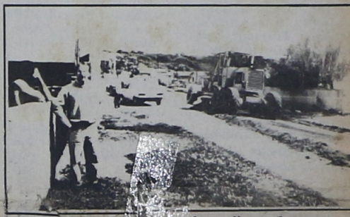
Prefeito supervisiona todos os dias as obras
