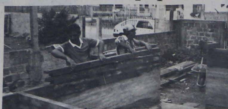
No novo sistema, os encaixes dispensam colunas e não precisa argamassa
