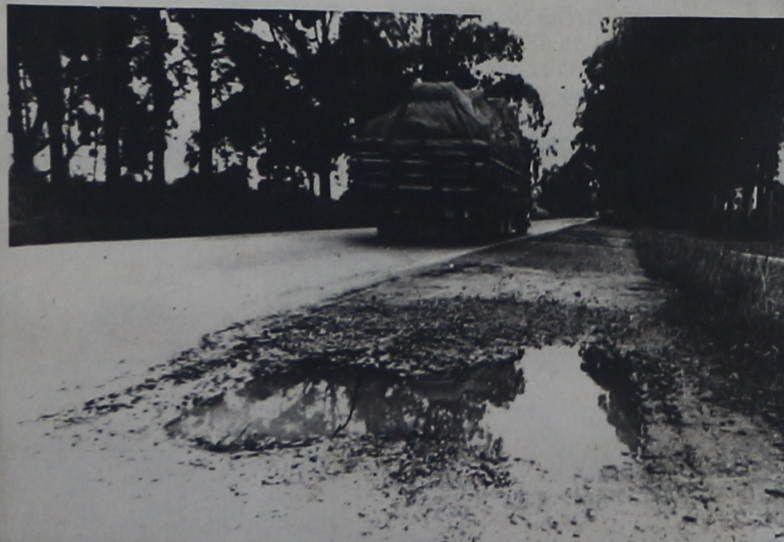
Buracos no acostamento e veículos avariados, uma constante, devido à má conservação
