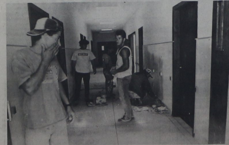
Operários dão os últimos retoques, na parte de pintura
