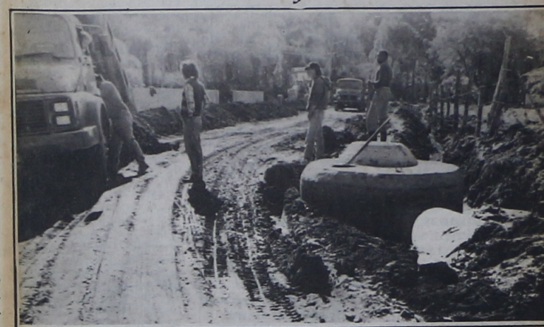
As caixas do emissário ficarão com fácil acesso e não atrapalharão o trânsito
