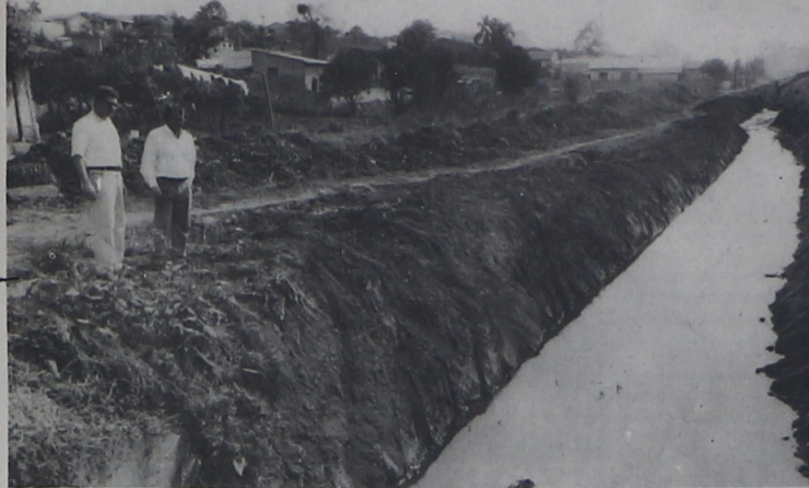
O prefeito Emídio Pianaro visita as obras de dragagem do Cambuí.
