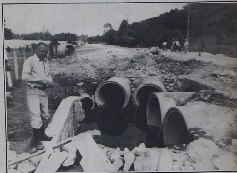
Os manilhamentos são verificados e desobstruídos, para impedir alagamentos
