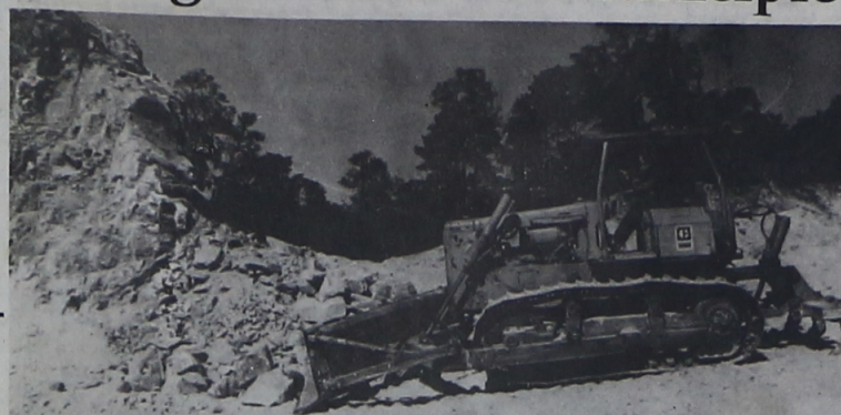
Máquinas do DER e da Prefeitura, numa grande operação de obras na Região Norte
