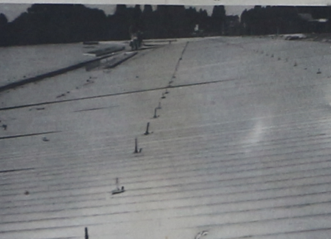
O telhado da Vila Olímpica, em obras de reforma e substituição de calhas
