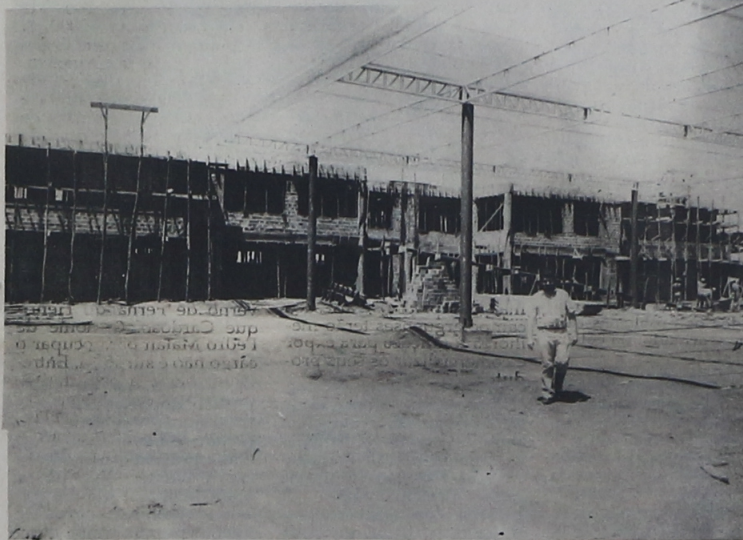
Valdemir Ramos da Quinta, mostra com entusiasmo, a parte mais importante da obra em execução
