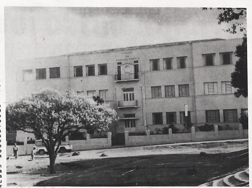
Colégio Sagrada Família, após recente reforma do prédio.
