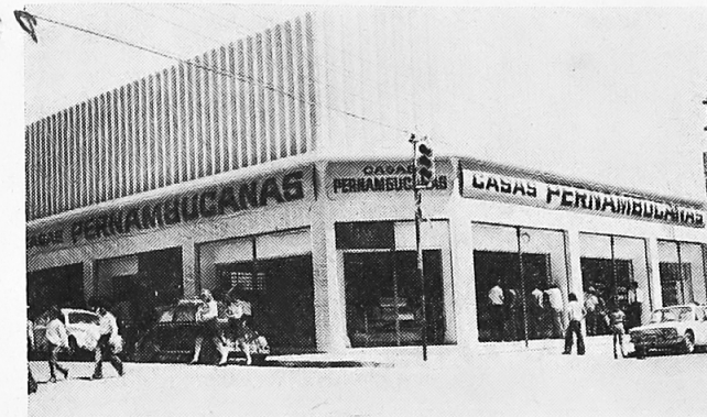
Fachada do novo Edifício
