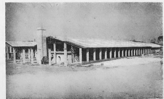
A Cerâmica Pelizzari Ltda., construída numa área de 3.850 m2, impressiona pelo tamanho e pela capacidade produtiva: 20.000 tijolos por dia.
