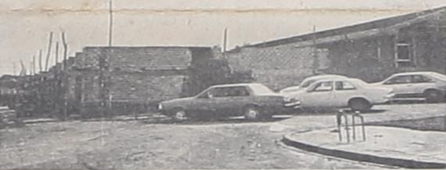
A construção já está em condições de receber a cobertura.
