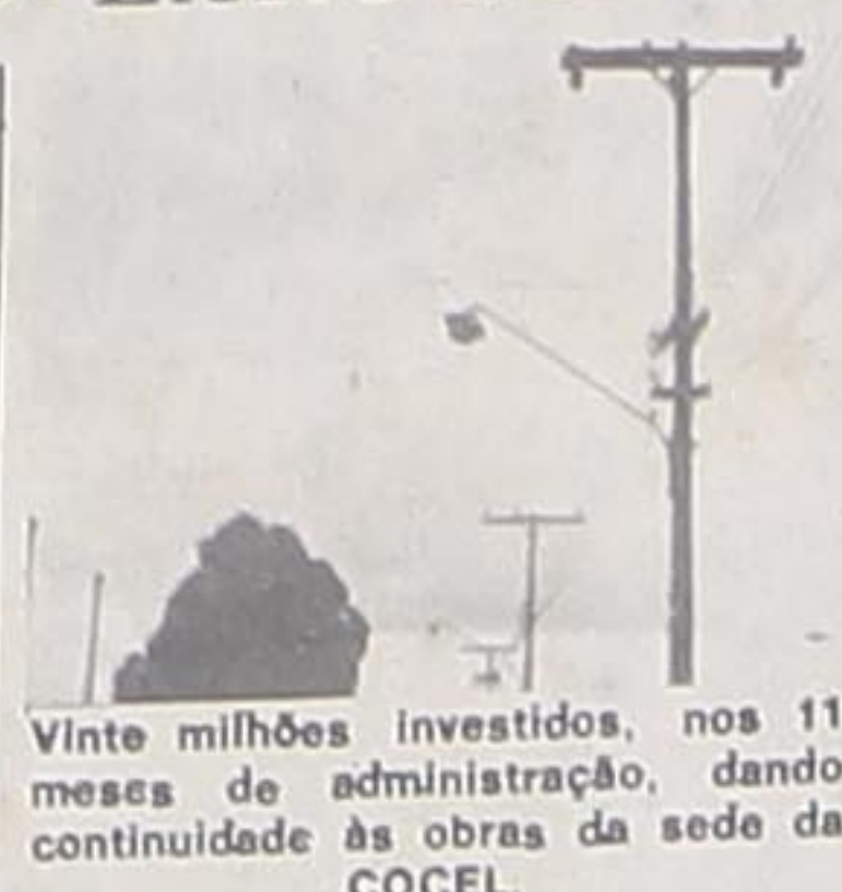
Vinte milhões investidos, nos 11 meses de administração, dando continuidade às obras da sede da COCEL.
