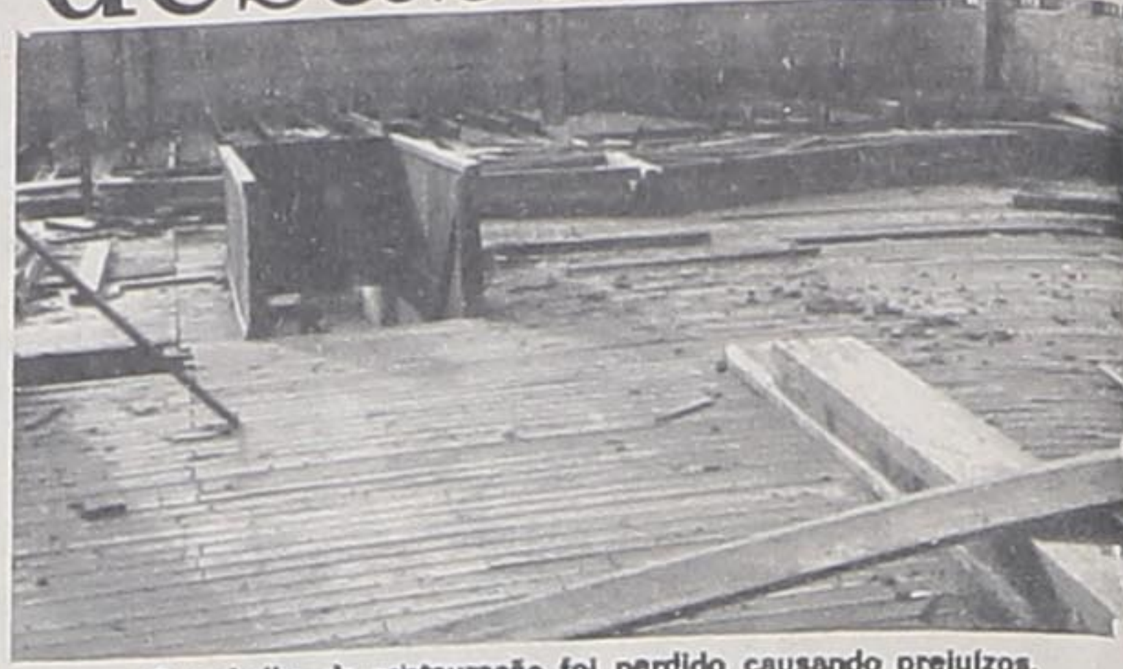
O trabalho de restauração foi perdido causando prejuízos.
