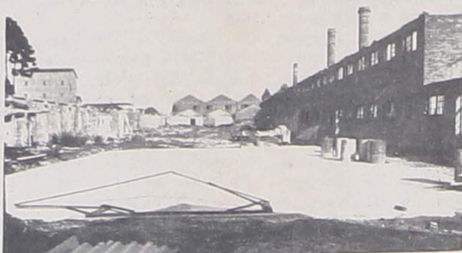
As estruturas encontram-se comprometidas e não oferecem segurança.
