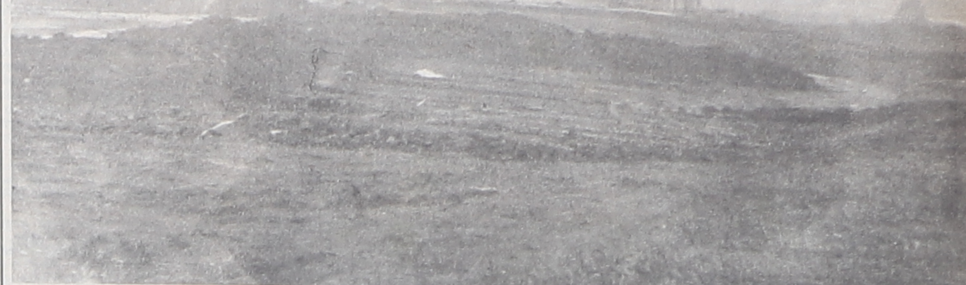
Com os serviços de terraplenagem na área, já começou a construção do cemitério.
