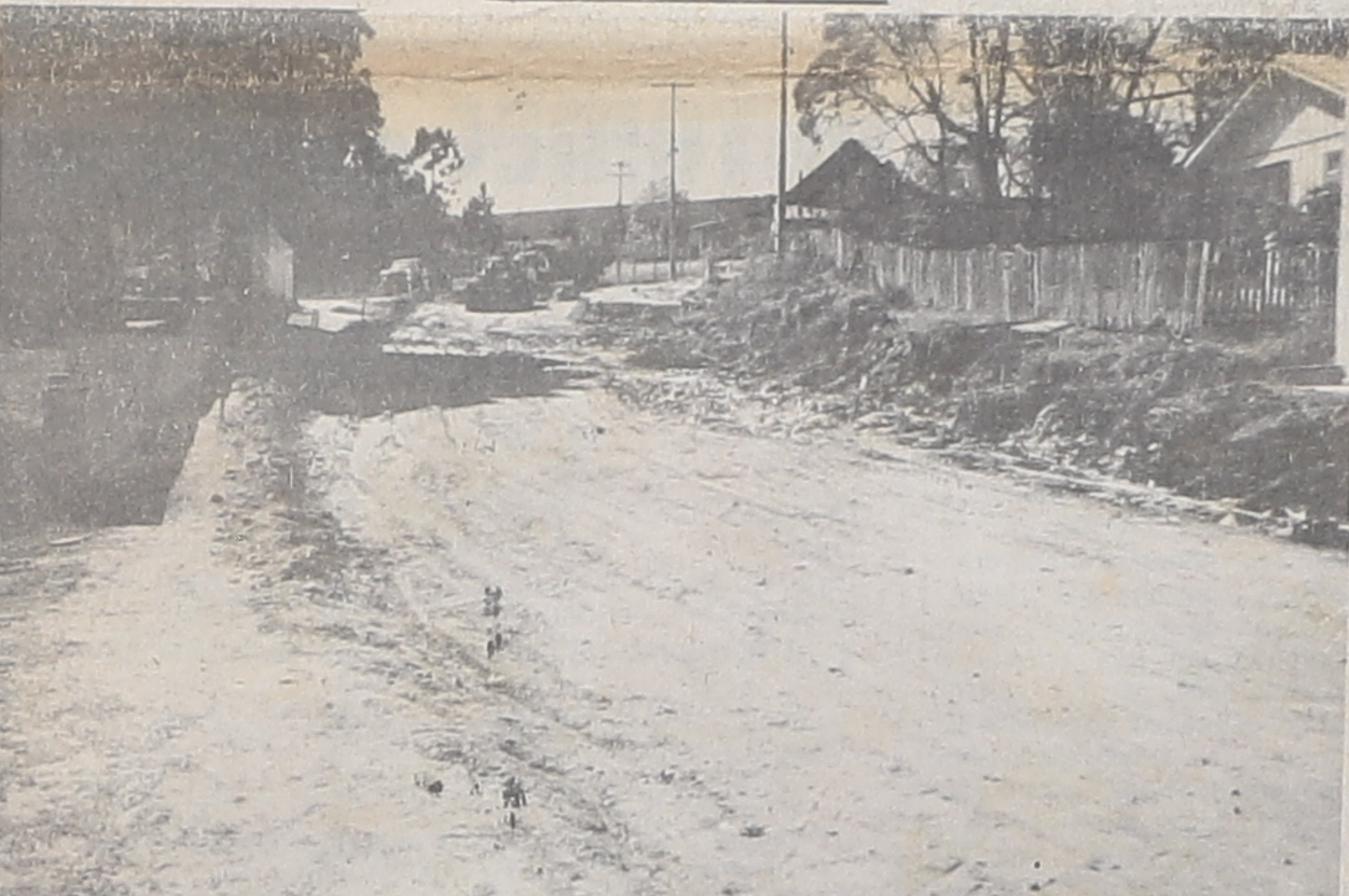
Com o preparo da base, realização de drenagem e infraestrutura básica, a rua Guilherme Bathke receberá a pavimentação com paralelepípedos.
