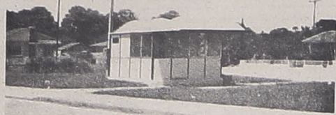
Totalmente concluído, o Módulo Policial Militar já está pronto para funcionar no Itaquí.
