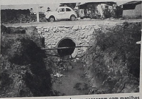
As ruas que cruzam o rio receberam passagem com manilhas de grande diâmetro.
