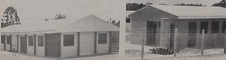
O Centro Social Rural de Ferraria já está concluído e será entregue à comunidade.
