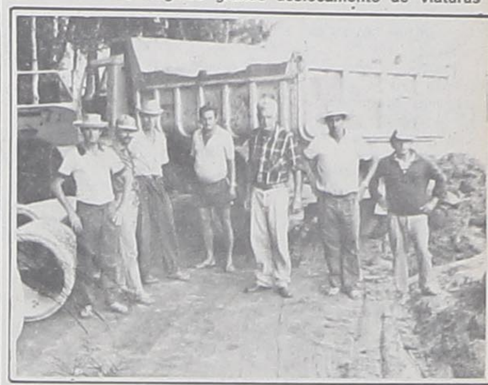
O Sr. João Alberto e uma das equipes encarregadas da instalação dos bueiros da nova estrada Onça/Retiro
