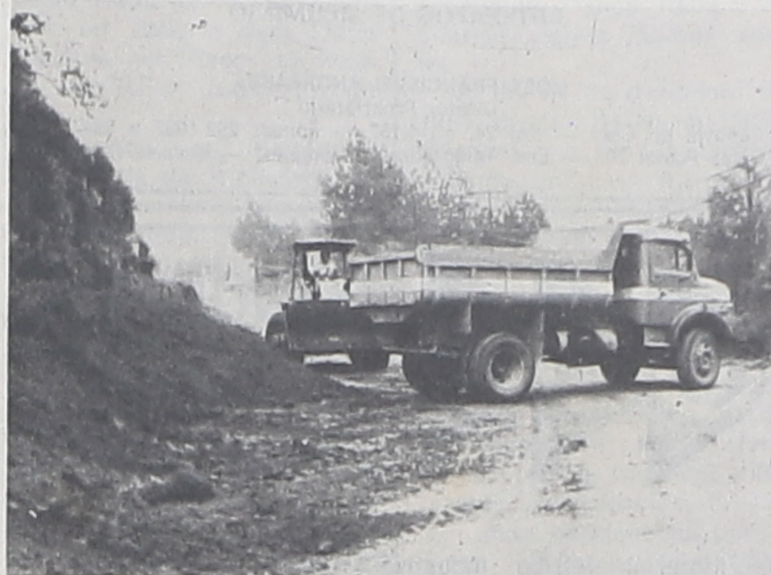
As máquinas já efetuam os trabalhos de retificação e terraplenagem na Estrada Mato Grosso.
