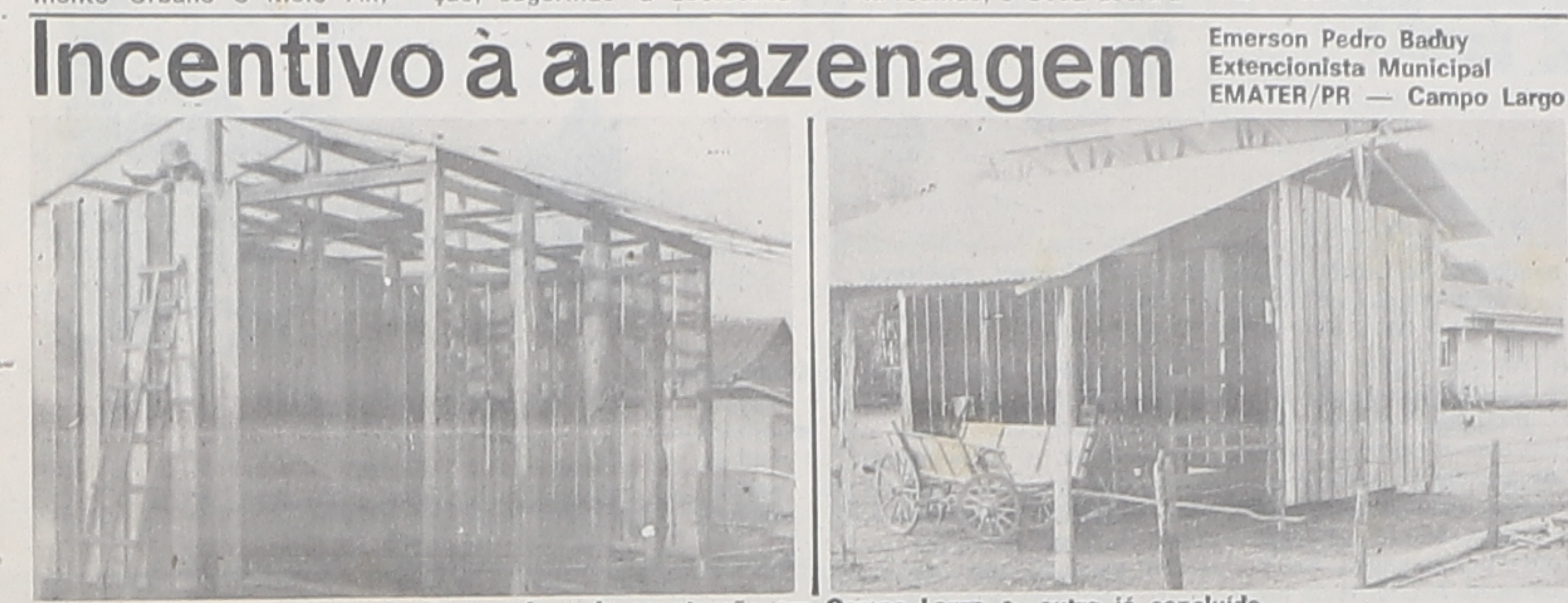
Um armazém em fase de construção em Campo Largo e outro já concluído.
