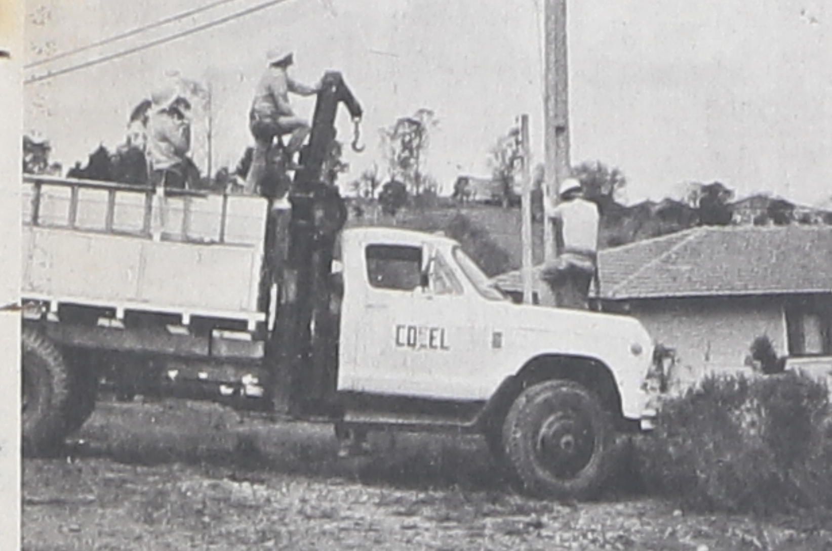
Atualmente a COCEL - Companhia Campolarguense de Eletricidade, pode se orgulhar em afirmar que implantou de 1983 a julho de 1988, 216 quilômetros de rede de energia elétrica na zona rural, reformou e ampliou a rede urbana em 107 quilômetros, totalizando 323 quilômetros, colocou 371 transformadores, 2.651 novas luminárias, 4.705 postes,
