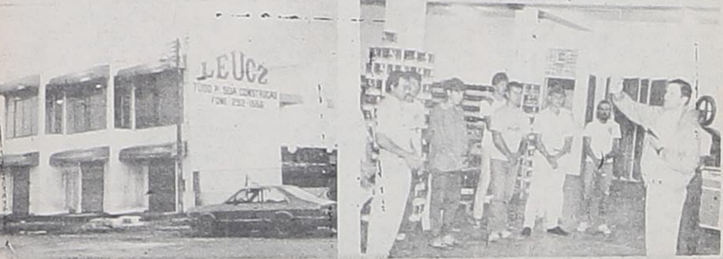
Em cerimônia simples foi entregue aos seus clientes, no último dia 18, com novo visual as confortáveis instalações da Leucz Materiais de Construção Ltda. A bênção das novas instalações foi efetuada pelo Pe. Angelo Carlesso.
