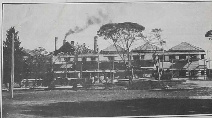
A Cerâmica Campo Largo, após um dos incêndios, em fase de reconstrução.
