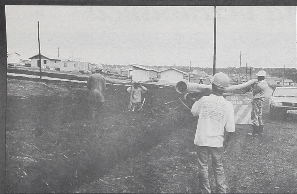
Obras de Saneamento no Bairro Novo - Sítio Cercado, em Curitiba.
