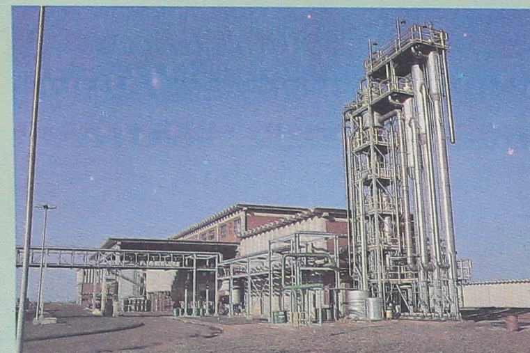
A indústria já está funcionando com o seu primeiro módulo
