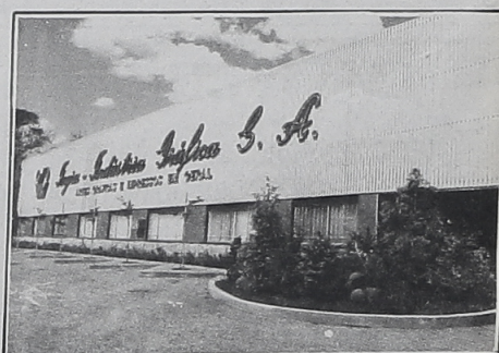
Sede da INGRA em Campo Largo: instalações amplas e modernas
